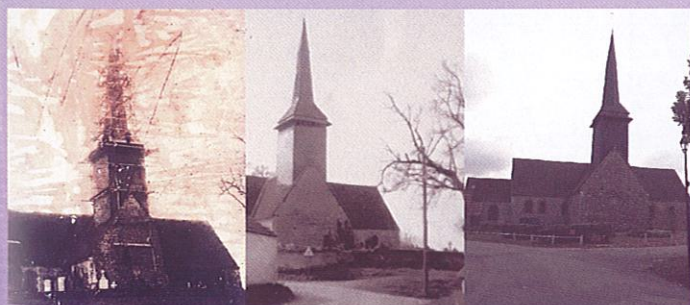
Restauration du clocher en 1911
